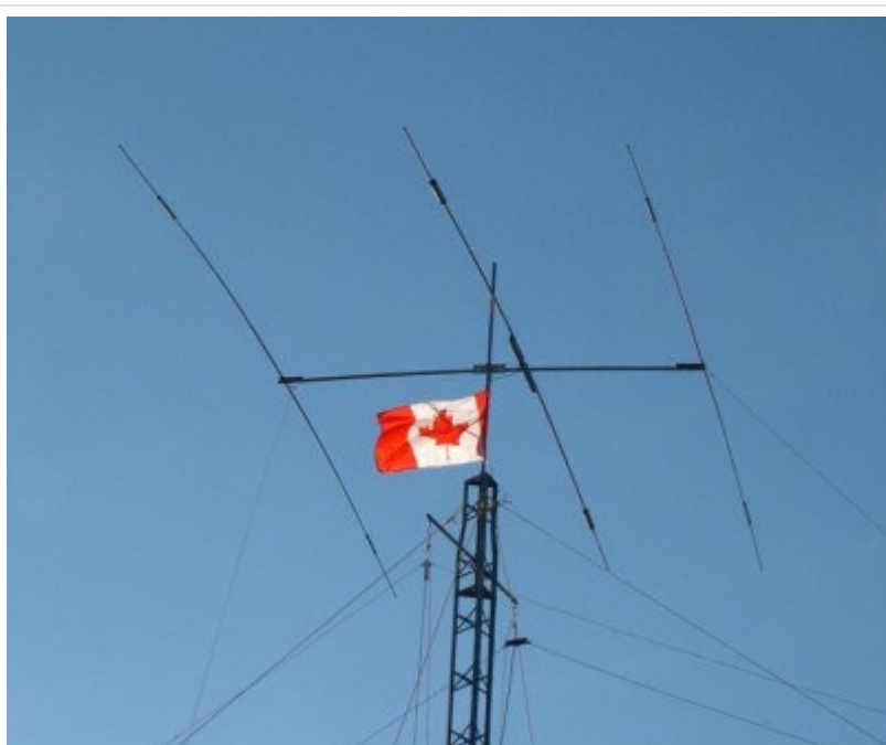
Obr. 10.7A.1 Praktická realizace Yagiho antény
